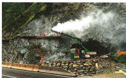
Der bestehende Naturtunnel (Bauvorhaben Niklasgalerie) wurde mit zirka 1.000 Meter doppelt korrosionsgeschützten Gewi-Stabankern gesichert.
