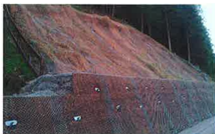
Im Bereich der Kemater Alm wurde eine vorgespannte, vernetzte Ankerwand errichtet.
